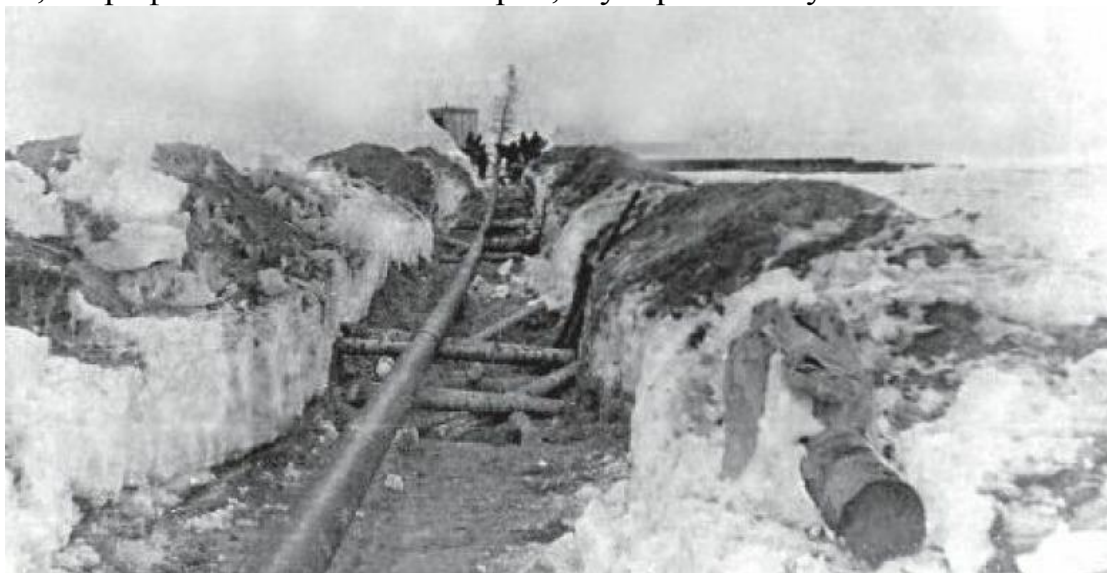
Строительство нефтепровода шло и зимой, в суровые морозы
